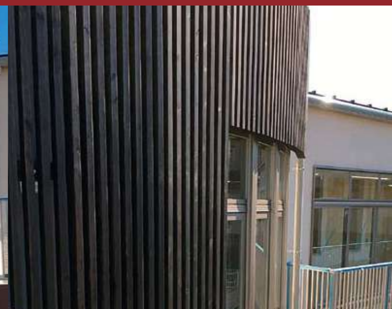
東中野島保育園 所在地/神奈川県横浜市 商品仕様/ObiRED デッキ材 水性半透明塗料塗装 4000×90×40 デッキ材を縦ルーバー材として使用。撥水性の高い塗料を塗装した上で、ユニット化した状態で納品しているため、現場での取り付けは大変スムーズに行うことができました。
