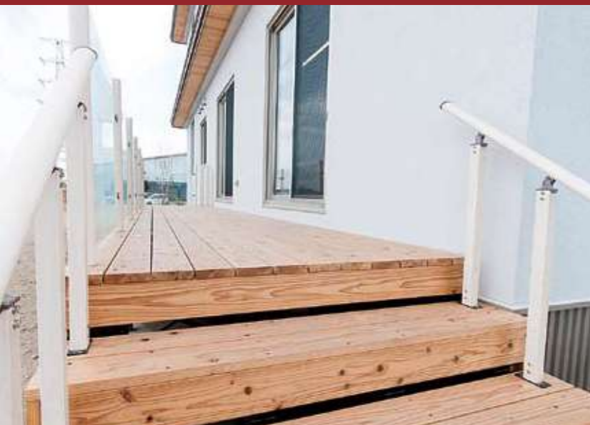
事務所 (仙台) 所在地/宮城県仙台市 商品仕様/ObiRED+Gywood デッキ材 無塗装 3900×130×25 事務所1階から、駐車場への連絡路として設置。表層圧密材を用いており、スギの無垢材でありながら、表面は硬く傷つきにくく、程よい衝撃吸収性と温かみを残しています。
