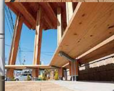
遠鉄バス バス停「蛸塚1丁目」（静岡県） 所在地/静岡県浜松市中区蛸塚1丁目14 商品仕様/ObiRED+AZN デッキ材 クリア塗装 4000×140×40 ObiRED+AZN デッキ材をバス停のベンチに使用。長期防錆・防蟻効果のある材料を屋外用の接着剤で幅はぎ接着し座面に用いています。熱伝導率が低いため、冬は暖かく、夏は暑くなり過ぎないので、優しい座り心地です。
