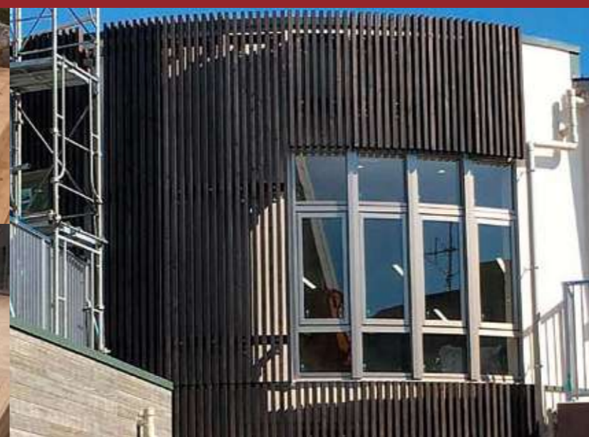
東中野島保育園 所在地/神奈川県横浜市 商品仕様/ObiRED デッキ材 水性半透明塗料塗装 4000×90×40 デッキ材を縦ルーバー材として使用。撥水性の高い塗料を塗装した上で、ユニット化した状態で納品しているため、現場での取り付けは大変スムーズに行うことができました。
