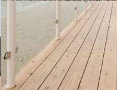
事務所 (仙台) 所在地/宮城県仙台市 商品仕様/ObiRED+Gywood デッキ材 無塗装 3900×130×25 事務所1階から、駐車場への連絡路として設置。表層圧密材を用いており、スギの無垢材でありながら、表面は硬く傷つきにくく、程よい衝撃吸収性と温かみを残しています。
