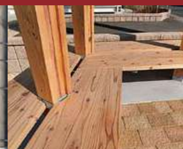
東中野島保育園 所在地/神奈川県横浜市 商品仕様/ObiRED デッキ材 水性半透明塗料塗装 4000×90×40 デッキ材を縦ルーバー材として使用。撥水性の高い塗料を塗装した上で、ユニット化した状態で納品しているため、現場での取り付けは大変スムーズに行うことができました。
